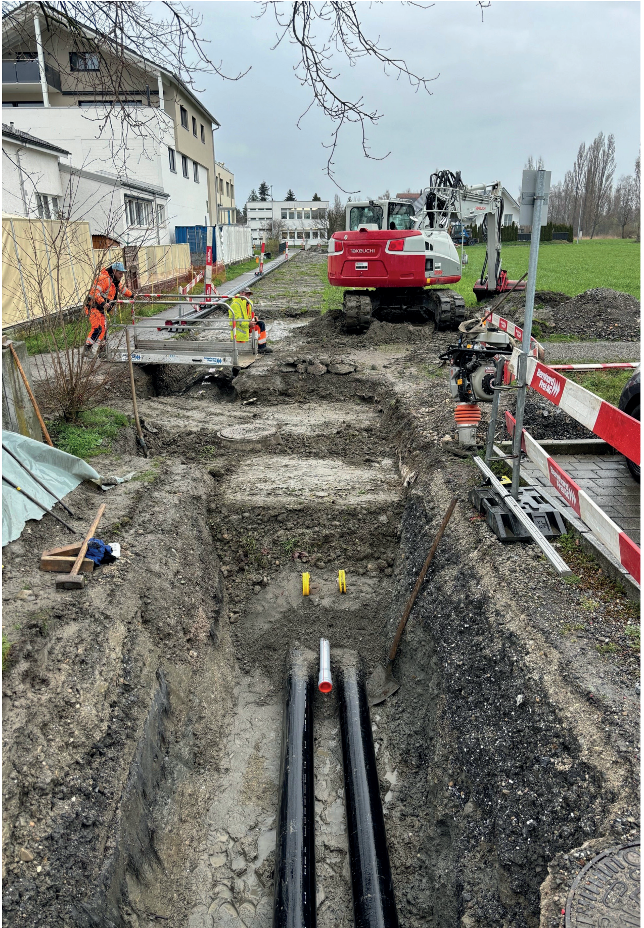
Anergieleitung Ringschluss
